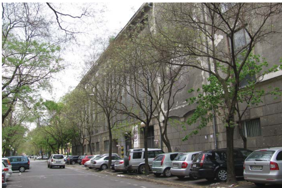
Pohľad z Blumentálskej ulice pred začatím búrania
