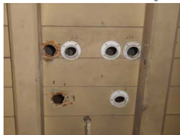
Otvory po trubním vedení jako schránka pro bodové osvětlení
